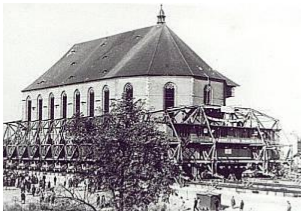
Kostel s ocelovou konstrukcí před přesunem
